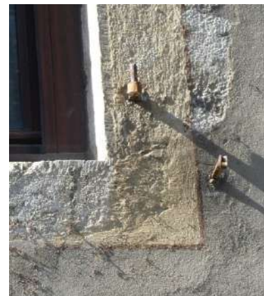
L'enduit vient à fleur de la pierre d'encadrement, enduit et pierre calcaire sont recouverts de badigeon, indifféremment.
