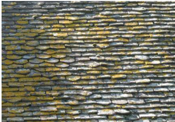
Tuiles plates et écaïlles mêlées sur couverture ancienne de dépendance de demeure nobiliaire rive droite
