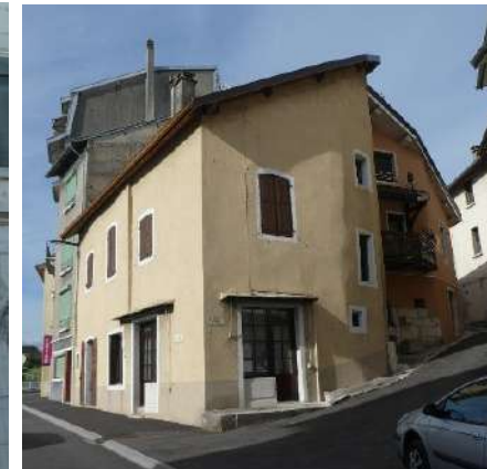
Allée Henri IV, angle quai du Rhône (ancienne maison noble) un volume à section polygonale et non pas circulaire
