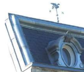
Lucarne en œil de bœuf, sur le bris d'un toit mansard orné d'un membron en zinc.
