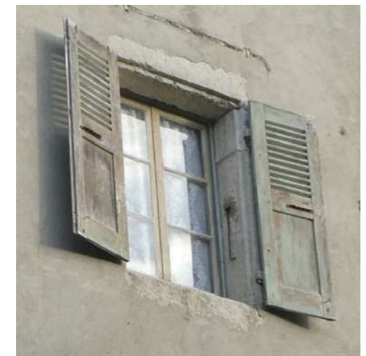
Vens : encadrement de fenêtre avec feuillure dans la pierre de taille pour recevoir les contrevents.
