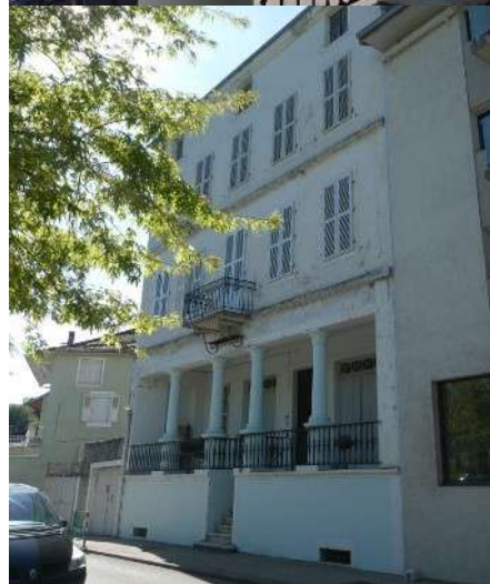
Loggia . quai Charles de Gaulle, garde-corps en fonte
