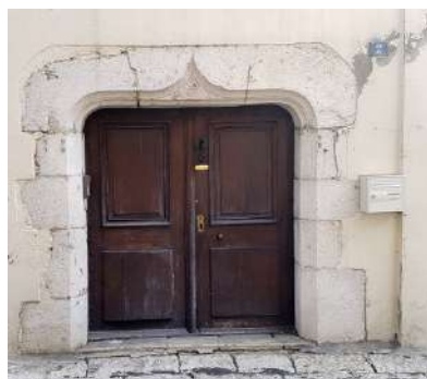
Linteau à platebande en accolade : un exemple exceptionnel : rue de Gérin (du XI e au XVI e siècle, les linteaux ne sont généralement employés que pour couvrir de petites ouvertures, et sont alors constitués d'une pierre unique. La platebande accompagne des styles d'architecture postérieurs (très rarement au XVI e siècle)
