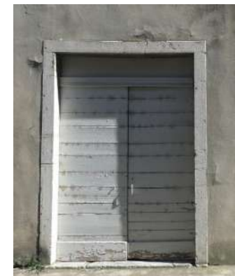
Porte bâtarde, entre porte cochère et porte piétonne. Ici, bien que l'imposte ait été condamnée, elle a conservé son dispositif d'origine : seuil en pierre de taille, planches larges croisées cloutées.
