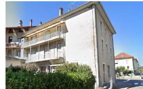
Maison de faubourg, rue de Savoie, coursives & garde-corps fer forgé
