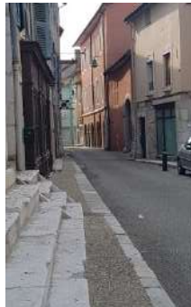
Les emmarchements et les seuils sont systématiquement en calcaire, l'homogénéité de teinte et de matériau avec les pierres d'encadrement des baies donne une belle unité aux espaces extérieurs.
