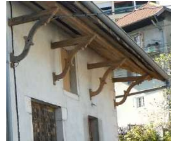
Consoles en bois chantourné, ouvragées de style Belle Époque supportant une panne volant et le lambrequin de la planche de rive et d'égout (remarquer que la gouttière se trouve dans le deuxième exemple à l'arrière, cachée par le lambrequin)
