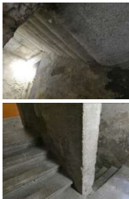
Escalier rampe sur rampe avec mur d'échiffre, immeuble orange place de la République, style XVII ème siècle
