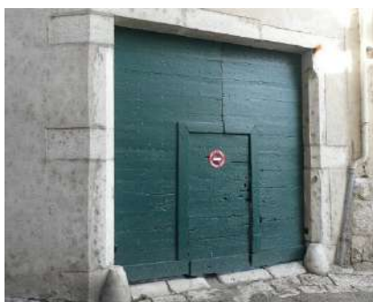
À linteau droit, rue de Gérin (le linteau a été refait en pierre mais a priori il était d'origine en bois), les piédroits sont chanfreinés, flanqués de chasse-roues
