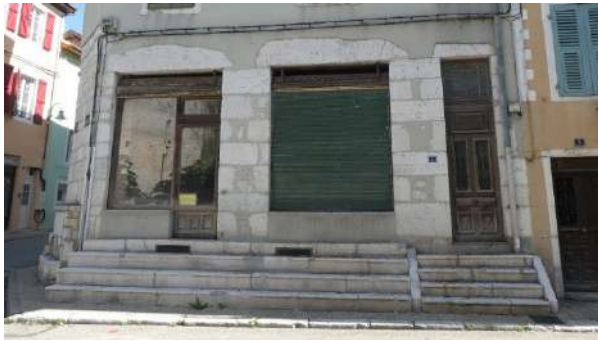
Les emmarchements et les seuils sont systématiquement en calcaire, l'homogénéité de teinte et de matériau avec les pierres d'encadrement des baies donne une belle unité aux espaces extérieurs.
