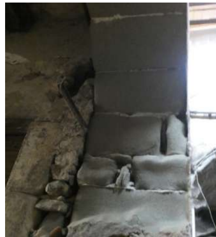
Allée, Seyssel 74, Grande Rue : arc constitué de claveaux de molasse
