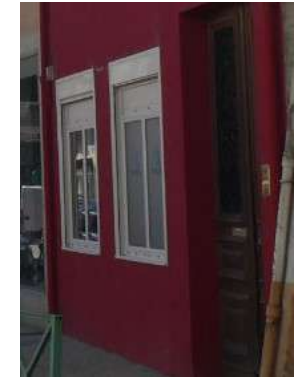
Pose de fenêtre au nu extérieur de la façade
