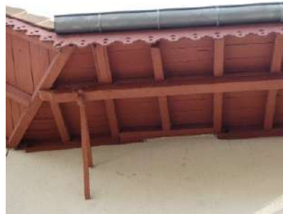
Consoles métalliques supportant les pannes volantes, permettant un généreux avant-toit avec grande légèreté
