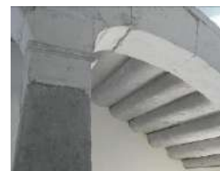
Escalier rampe sur rampe, avec arcs en pierre de taille et voûtes d'arête sur les paliers et repos, supposé fin XVII ème siècle, allée de Richemond.
