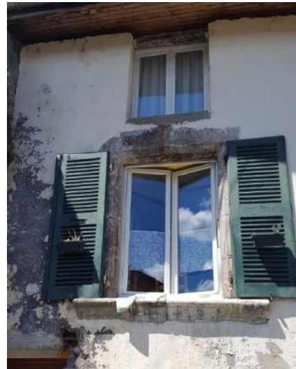
Encadrement de fenêtre chanfreiné sur appui de fenêtre mouluré
