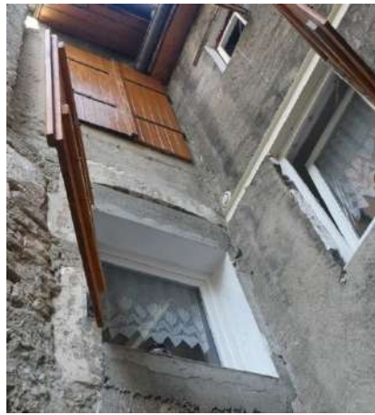
Encadrement de fenêtre en pierre de taille réduit au béton pour poser une fenêtre standardisée en plastique
