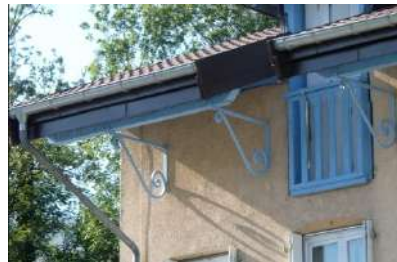
Consoles métalliques supportant les pannes volantes, permettant un généreux avant-toit avec grande légèreté
