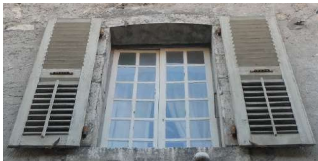
Rue de Gérin, sur deux immeubles (hôtel de Belmont et couvent des Ursulines) les menuiseries (et parfois les vitrages) sont conservés du XVIII ème siècle. Les menuiseries sont contemporaines de l'encadrement en pierre de taille (linteau délardé en arc surbaissé). En revanche l'appui filant de l'hôtel Belmont et les piédroits moulurés datent vraisemblablement du XVI ème siècle.
