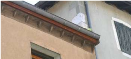
Corbeaux de bois supportant les chevrons
