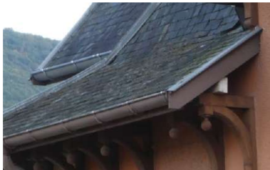
Tuiles plates et écaïlles mêlées sur couverture ancienne de dépendance de demeure nobiliaire rive droite
