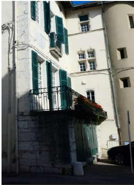
terrasse de l'hôtel Belmont, place de la République, couronnée d'un garde-corps en ferronnerie du
