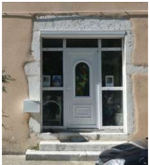
Les emmarchements et les seuils sont systématiquement en calcaire, l'homogénéité de teinte et de matériau avec les pierres d'encadrement des baies donne une belle unité aux espaces extérieurs.
