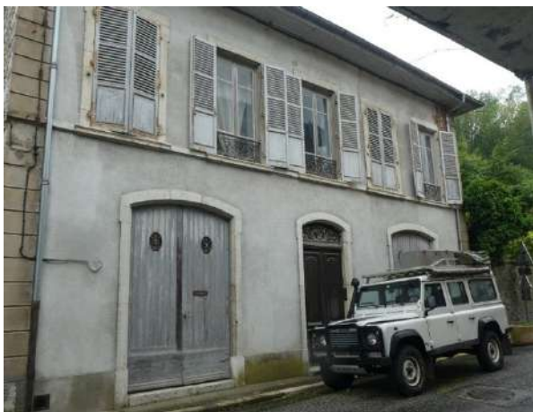
Maison supposée XIX ème siècle dont le rez-de-chaussée est réservé aux dépendances
