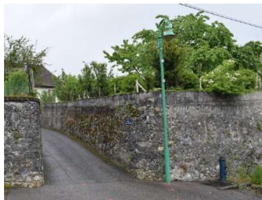
Soutènement : accès modifié au clos des capucins
