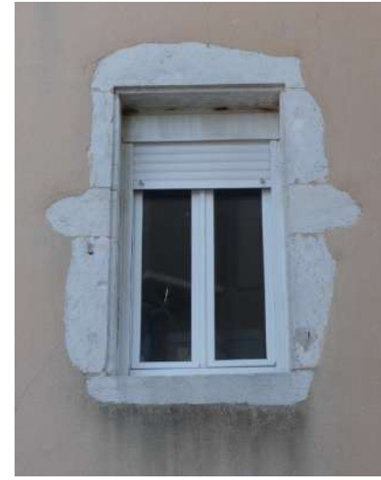
Diverses menuiseries en plastique blanc, avec retombées de coffre de volet roulant, pose en rénovation diminuant le clair de vitrage, pose au nu extérieur, etc.
