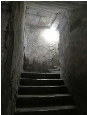
Escalier rampe sur rampe avec mur d'échiffre, immeuble orange place de la République, style XVII ème siècle
