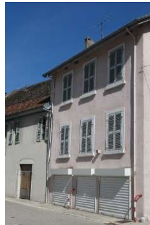
Coffres saillants de volets roulants en façade (et arceaux rouges et blancs)
