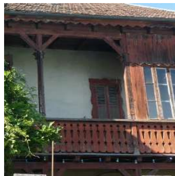
Jeu entre coursive, loggia et bow window: sur jardin/quai, villa du Rhône, Belle Époque
