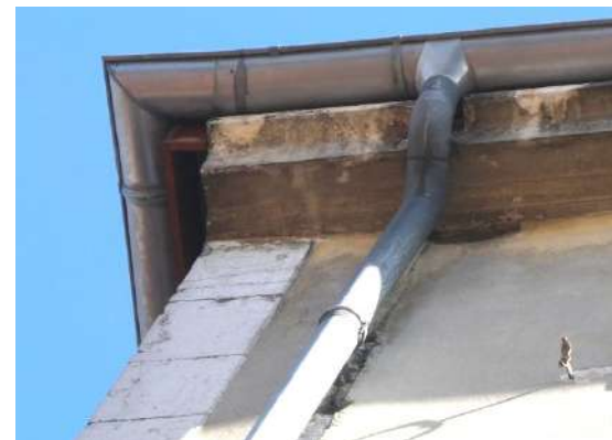
Rue Churchill : corniche dont on observe, au percement qui n'a pas été rebouché, qu'elle portait un chéneau encastré cf. détail ci-contre.
