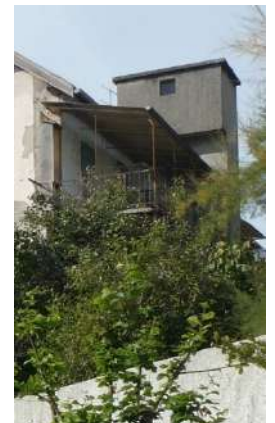
Des édicules et appentis qui perturbent la lecture des volumes de toitures caractéristiques de Seyssel
