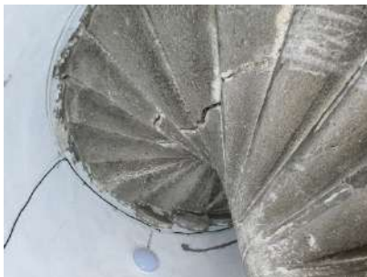
Vue intérieure du même escalier
