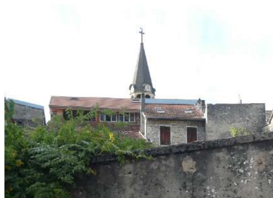
Des rehausses de toit sans rapport avec la volumétrie initiale et traditionnelle
