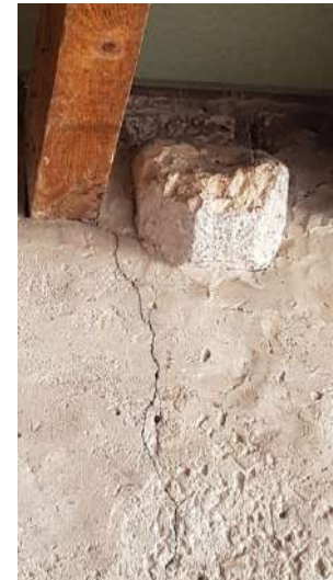
Vestige d'arc ou de corbeau chanfreiné en plancher haut d'un rez-de-chaussée
