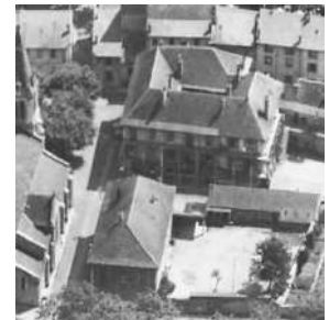
Immeuble démolit pour opération SEMCODA) rue de Churchill)
