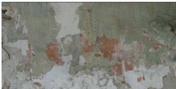
L'enduit vient à fleur de la pierre d'encadrement, enduit et pierre calcaire sont recouverts de badigeon, indifféremment.
