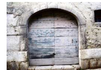
Rue de Gérin : arcade en anse de panier sur piédroits droits
