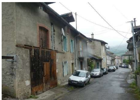
Dépendance agricole mitoyenne à la maison d'habitation
