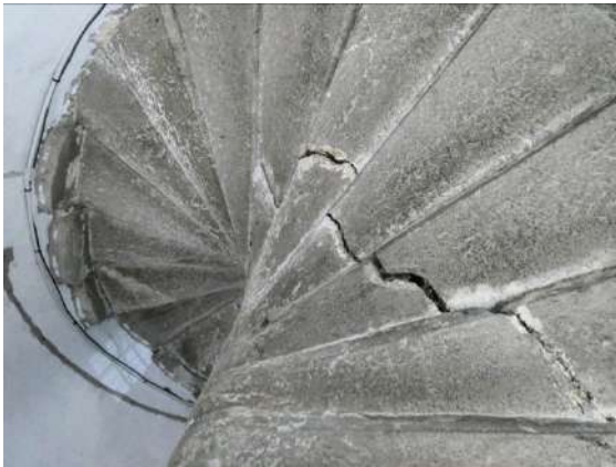
Escalier en vis, place de la République, XV ème siècle à XVI ème siècle
