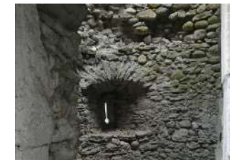
Tour du château de Coligny : maçonnerie tout venant, la molasse est utilisée à la marge, les galets sont dominants.
