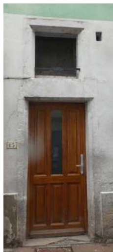
Portes surmontées de fenêtres d'imposte datables des XV ème à XVII ème siècle : les pierres de taille d'encadrement sont généralement ornées d'un chanfrein, le linteau peut être mouluré d'une accolade.
