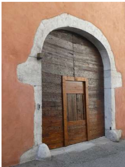
En arcade, rue Churchill, donnant accès à un hôtel particulier : arc en anse de panier sur piédroits droits, chasse-roues
