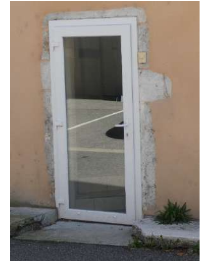
Diverses menuiseries en plastique blanc, avec retombées de coffre de volet roulant, pose en rénovation diminuant le clair de vitrage, pose au nu extérieur, etc.
