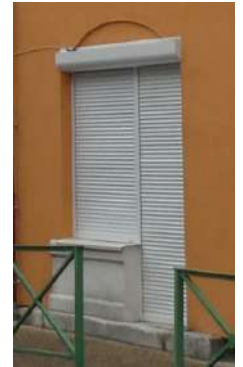
Boutique banalisée (volet roulants coffré apparent en saillie, enduit orange sur ITE)
