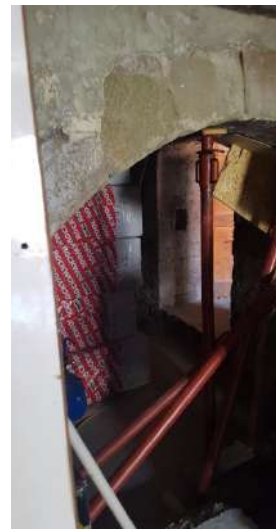
Arc de rez-de-chaussée supportant le plancher bois du niveau supérieur
