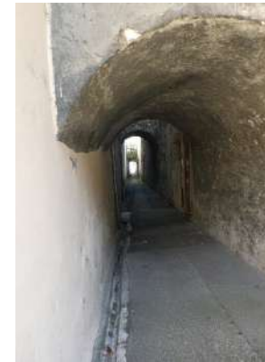
Rue Neuve : caniveau latéral en pierre calcaire, taillée en demi-rond
