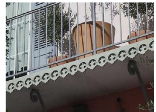
Rue Roosevelt : balcon à barreaudage vertical simple de fers ronds La dalle de balcon semble être en béton, supportée par des consoles métalliques à enroulement, sa tranche est habillée d'un lambrequin de bois peint
