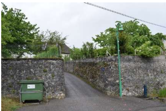
L'accès est encadré de deux murs de soutènement qui tranchent dans une plateforme, vestige possible du dispositif défensif ancien.
