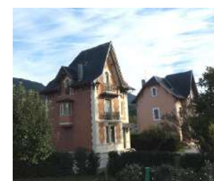
avant-toit de bois, courbe (golasse ?) surmontant une moulure ciment tirée au gabarit)
