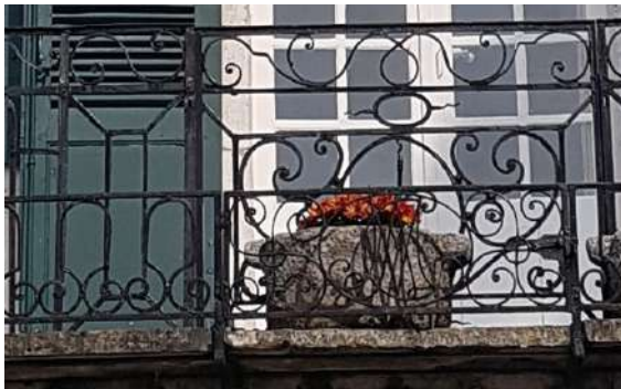
Balcon et terrasse avec garde-corps en fer forgé du XVIII ème siècle (Louis XV à vérifier) sur l'hôtel de Belmont, place de la République
