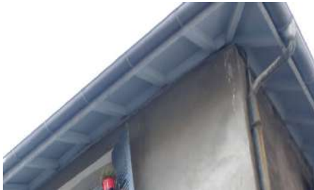
Dépassées avec chevrons apparents
