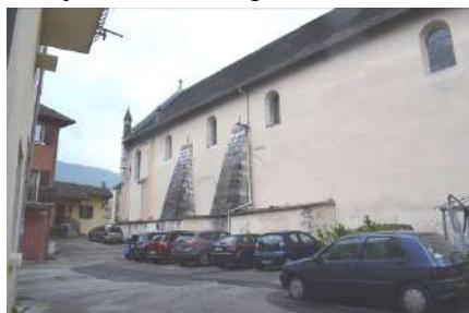
2. Façade sud de l'église
