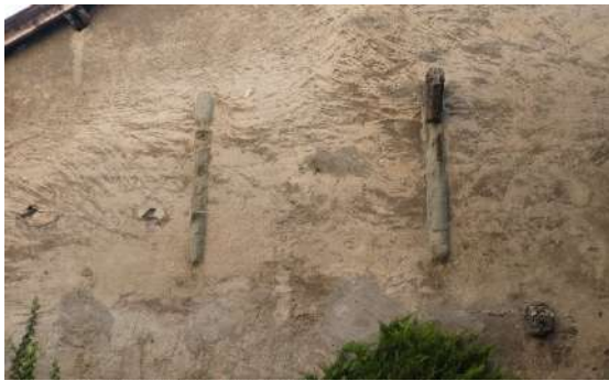
Piédroits d'une cheminée supportée XV ou XVI ème siècle sur un mur de refends devenu mur de façade
