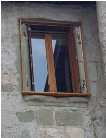
Cadre bois rajouté devant un encadrement en molasse moulurée supposé XVI ème siècle
