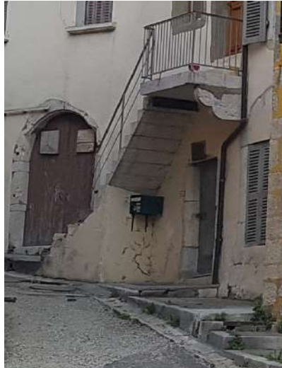
Allée Henri IV : escalier en partie maçonné en en partie en en porte à faux, le balcon repose sur une console en pierre de taille qui peut dater du XVII ème siècle
