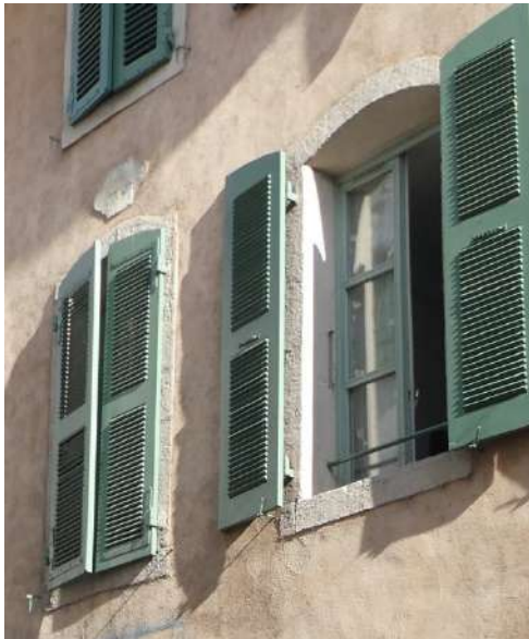
Ci-dessus, Grande Rue, ancien hôtel particulier : au-dessus d'une des fenêtres, une date inscrite sur médaillon : 1785. Si les encadrements sont datés de En revanche les menuiseries et enduit sont du XX ou XXI ème siècle).
