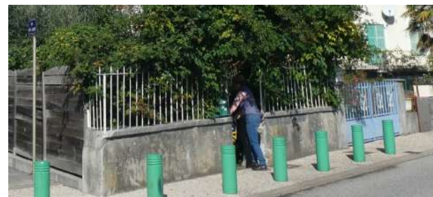
Rue Saint-Joseph : le percement de la rue a généré, dans le prolongement du pignon bâti, une clôture « pansement » en bois en lieu et place d'un retournement de clôture en serrurerie sur le mur bahut.
