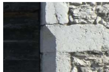
Boulevard Bonivard : piédroit de réemploi (démolitions voie ferrée ?)
