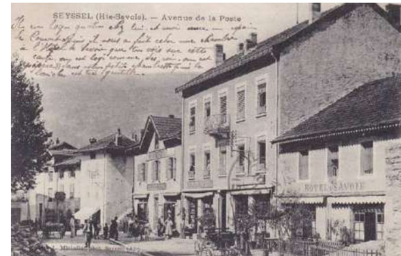
Ici remplacées par des volets roulants
