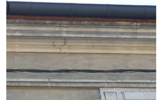
Corniche fin XIX e siècle début XX e siècle : immeuble Belle Époque
