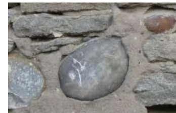
Tour du château de Coligny : maçonnerie tout venant, la molasse est utilisée à la marge, les galets sont dominants.
