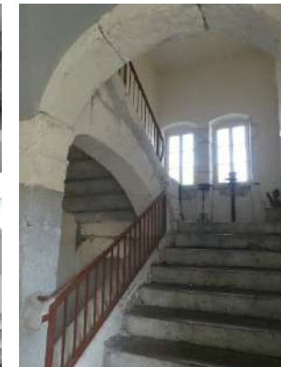
Escalier rampe sur rampe, avec arcs en pierre de taille et voûtes d'arête sur les paliers et repos, supposé fin XVII ème siècle, allée de Richemond.
