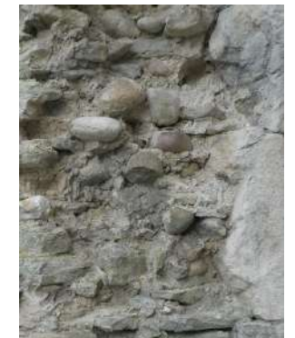
Tour du château de Coligny : maçonnerie tout venant, la molasse est utilisée à la marge, les galets sont dominants.
