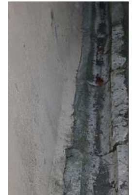
Rue Neuve : caniveau latéral en pierre calcaire, taillée en demi-rond
