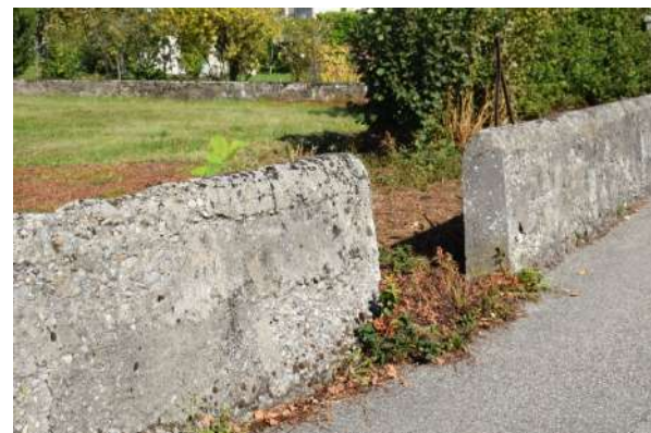
Mur en béton de site, coulé en place
