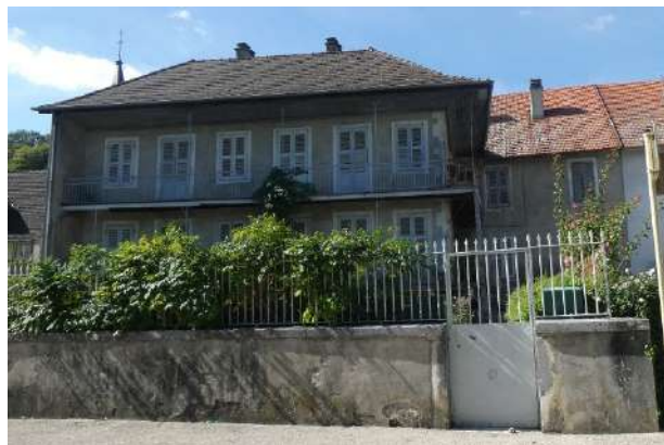
Grille de jardin sur mur bahut . La plantation de grim-pantes sur la grille offre du végétal sur la rue tout en offrant un filtre pour l'intimité.
