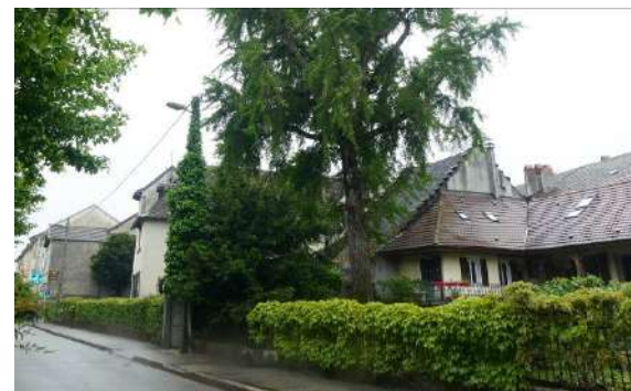
Grille de jardin sur mur bahut . La plantation de grim-pantes sur la grille offre du végétal sur la rue tout en offrant un filtre pour l'intimité.
