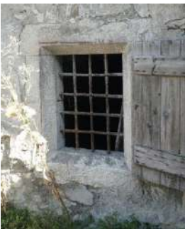
Rue Churchill, fenêtres chanfreinées
