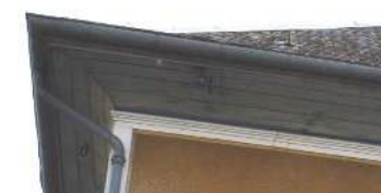
avant-toit de bois, courbe (golasse ?) surmontant une moulure ciment tirée au gabarit)
