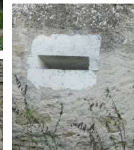
Coligny, jours de ventilation de cave situées au rez-de-chaussée
