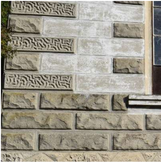
Rue Gérin, en imitation de la pierre (motifs de bossages, de pierre vermiculées. On observe que selon les éléments, ils étaient ou non badigeonnés.
