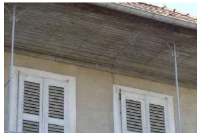
Avant toit en bois cintré (golasse ?) la panne volante repose sur de fin potelets en serrurerie
