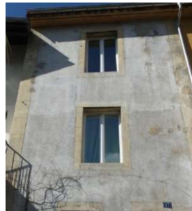
Façade rue Roosevelt
