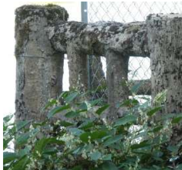
Clôture formant garde-corps, jardin en terrasses sur le Rhône de Seyssel rive gauche
