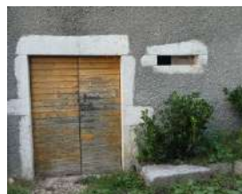
Coligny, jours de ventilation de cave situées au rez-de-chaussée
