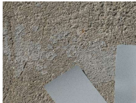
Vestiges de badigeon gris bleuté sur façade enduite avec finition talochée : une finition courante en particulier dans les deux noyaux urbains.
