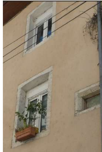
Diverses menuiseries en plastique blanc, avec retombées de coffre de volet roulant, pose en rénovation diminuant le clair de vitrage, pose au nu extérieur, etc.
