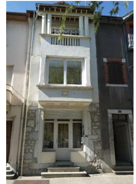
Bow-window en béton armé sur les
