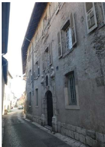
Rue de Gérin : façade ordonnancée, sous-bassement en pierre de taille, et portail
