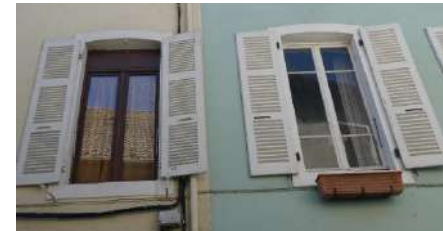
Fenêtre banalisante et fenêtre adaptée sur deux baies identiques
