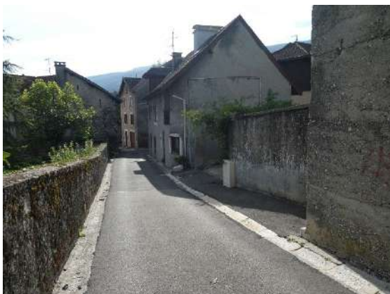
La rue des Remparts vue depuis l'intérieur de la ville
