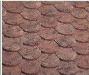
Tuile plate traditionnelle, écaille. Pose traditionnelle (60/m 2 ). Le recouvrement est important, seule la partie arrondie dépasse, les toitures sont plus épaisses, c'est la caractéristique des toitures anciennes
