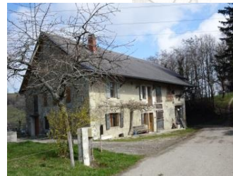
Rte des Corbattes-219_OH- 567_ Ancienne ferme qui a encore ses caractéristiques
