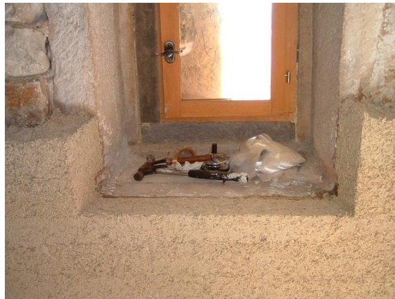
Oui - à l'intérieur un enduit chanvre et chaux pour couper l'effet de paroi froide
