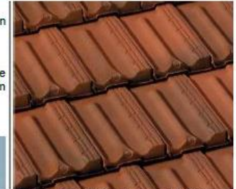
Tuile mécanique traditionnelle, à côte (13 à 20 tuiles/m 2 ). Dimensions courantes 21,5/35cm
