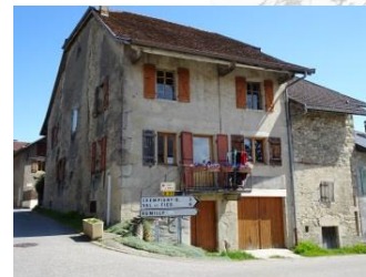
Rue du Centre-122_OH-755-1810 Architecture traditionnelle rurale avec escalier en pierre
