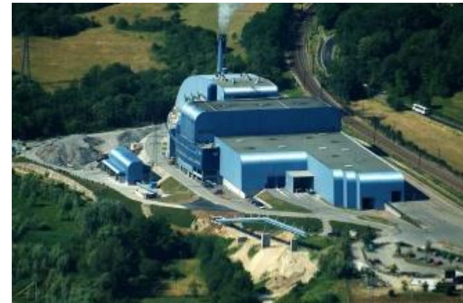
Usine de Valorisation Energétique du SIFAGE
