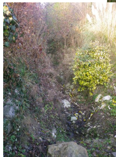
Cours d'eau en amont des habitations envahi de végétation
