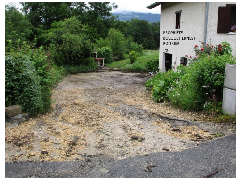
Propriété sinistrée (Source: mairie de Chavannaz – juin 2016)
