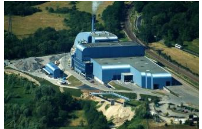
Usine de Valorisation Énergétique du SIDEFAGE
