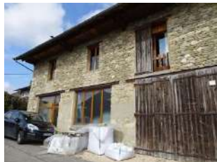
Rue de l'Ecole-63_OH-743 Ancien atelier
