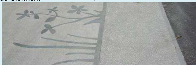
Béton sablé, motifs non sablé (Fontaine – Isère)
