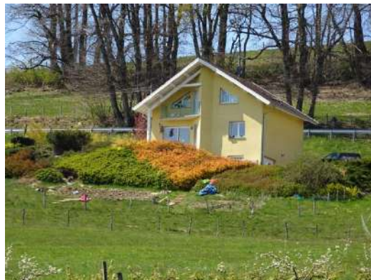
Exemple de bâtiment non patrimonial, il n'est pas répertorié sur la carte de l'AVAP. Maison Route de Droisy-595_pOH-1873
