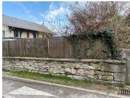
Rue du Centre_p684
