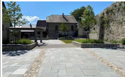
Clermont : Aménagement de l'esplanade de l'église Dallage de pierres de luzerne et bandes type calade
