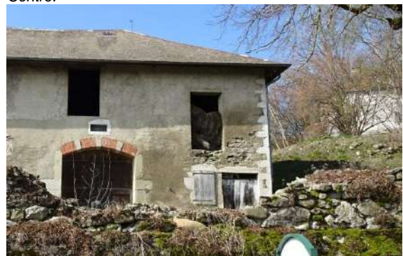
Pierre (calcaire et molasse) et briques, impasse de l'Eglise
