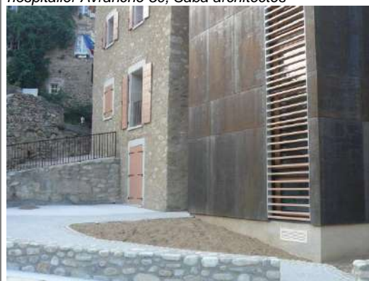
Extension d'un bâtiment traditionnel en métal et clins de bois. Mairie Le Tech 66.
