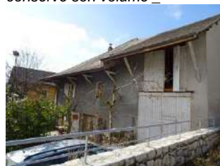
Rue du Centre-9_OH-690 Ancienne ferme, façade sur impasse de l'Eglise
