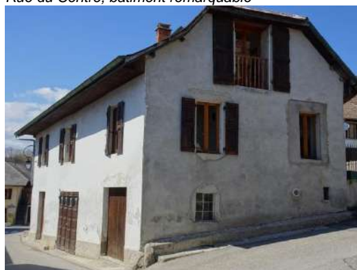
Rue du Centre, bâtiment intéressant
