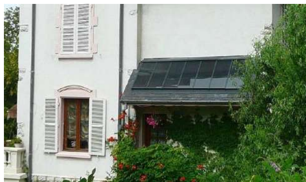
Intégration sur un auvent
