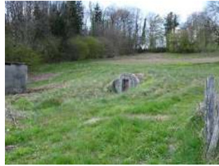
Impasse des Sources_OH-1416-1420 source captée
