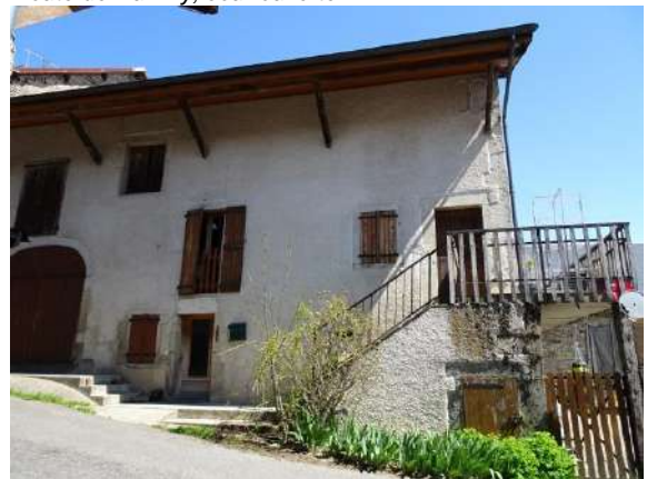
Passage de l'Atelier, cour ouverte, végétalisée
