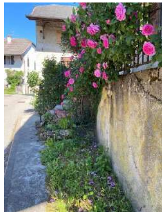
Clermont : pied de mur végétalisé
