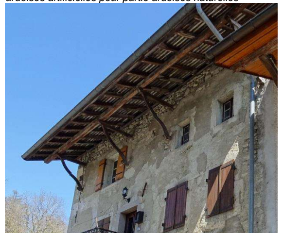
Passage de l'Atelier, lattis et voligeage apparent en sous-face
