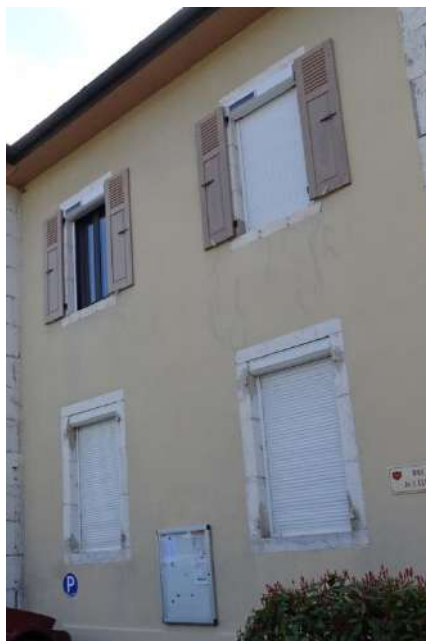
Non : dépose des volets au rez-de-chaussée, pose de volet roulant en pvc blanc
