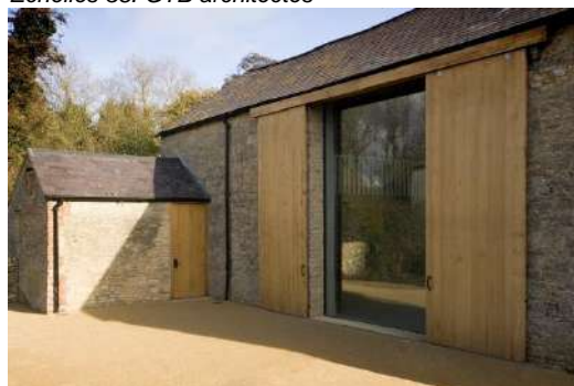
Volets coulissants pour occulter une baie vitrée.
