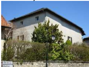
Rue du Centre-113_OH-1538 Maison_
