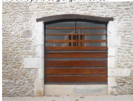
Ancienne porte de grange Royans, 38
