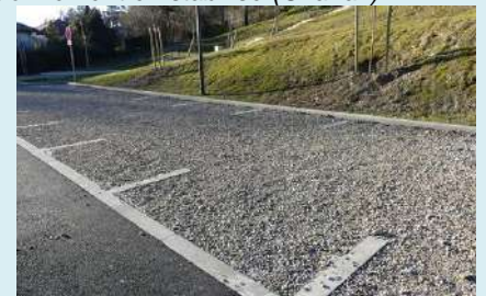
Circulation en enrobé et emplacements en stabilisé (Bonne, Haute-Savoie)
