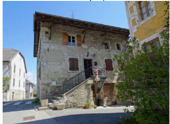
Ancienne ferme avec fonctions superposées et escalier d'accès à l'étage
