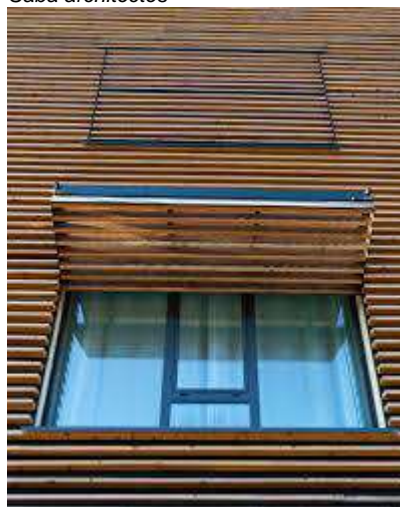
Volet bois pliant. Maison de retraite Miribel les Echelles 38. GTB architectes
