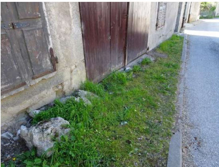
Rue du Centre, pied de mur enherbé
