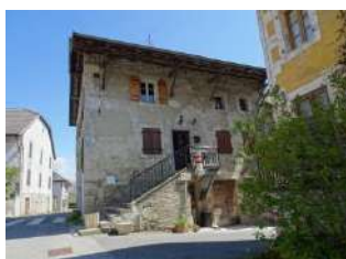
Passage Atelier-3_OH-740 Ancienne ferme représentative de l'architecture rurale
