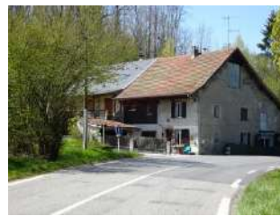
Impasse des Esserts-6-20_OH-1201-1204_ Ancienne ferme
