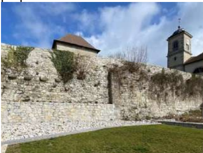
Mur du château Esplanade de l'Eglise
