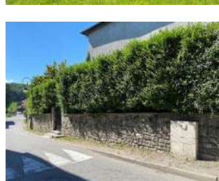
Rue du Centre_p1538
