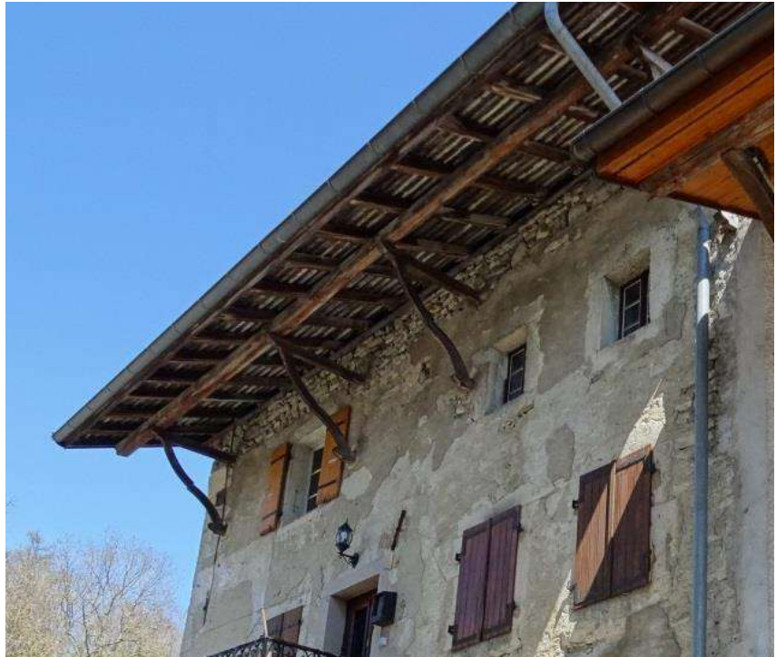
Passées de toits caractéristiques de Clermont à respecter
