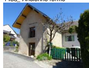
Rue Mont Pely-19_OH-728_ Ancienne ferme
