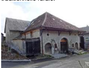
Rue du Centre-12_OH-689 Bâtiment agricole en angle qui occupe toute la parcelle
