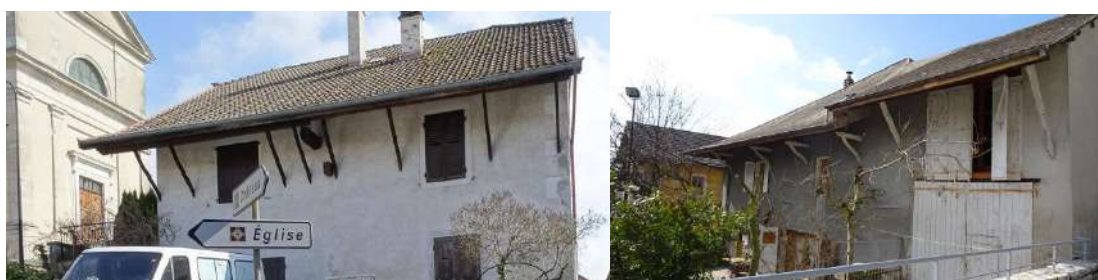
avancées de toitures caractéristiques de Clermont
