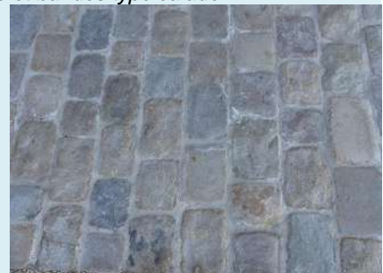
Pavage jointoyé – place de l'église à Haute-Bonne
