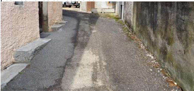
Clermont, Passage du Vieux Village: Enrobé recouvrant tout l'espace, jusqu'au pied des façades, qui unifie l'espace public et lui donne un caractère routier, altère les perceptions visuelles et ne participe pas à la mise en valeur du patrimoine bâti, imperméabilise les sols et dégrade les murs anciens
