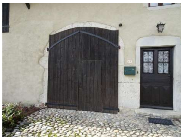
Ancien placéage, Sol d'origine mis en valeur (calade)
