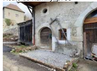
Rue du Centre_p689
