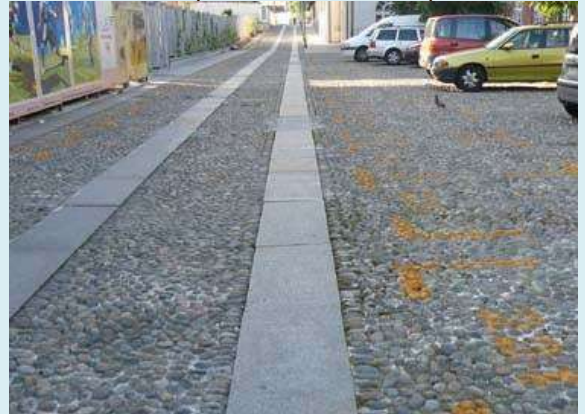
Calade pour l'ensemble de la rue et dalles de granit pour les bandes de roulement (Turin, Italie). Ce mode de disposition permet d'amoindrir le bruit du passage des voitures dans la rue.
