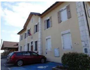
Rue de l'Ecole-10_OH-2009_ Ancienne mairie-école
