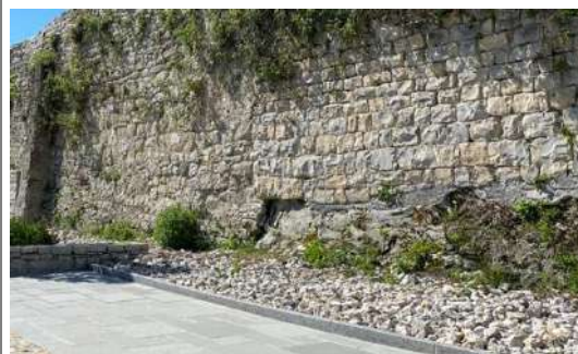
Clermont : Aménagement de l'esplanade de l'église, pied de mur perméable
