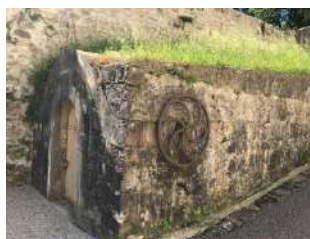
Impasse de l'église_source et pompe à bras.
