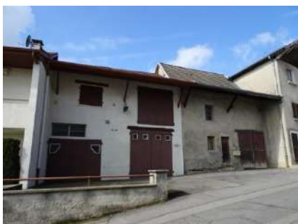
Traitement de sol en enrobé Rte de Rumilly_p676-677
