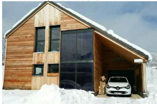
Panneaux solaires composant une façade. Source : Solisart.fr
