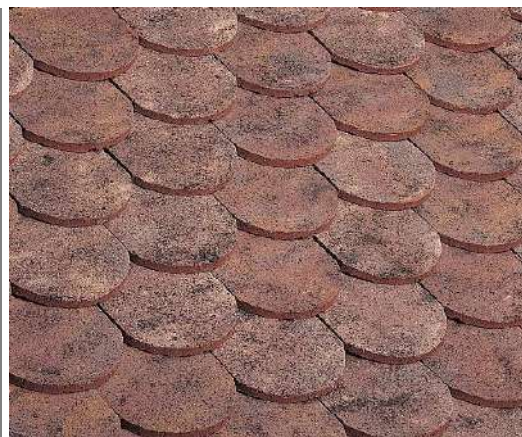
Tuile plate traditionnelle, écaille. Pose traditionnelle (60/m 2 ). Le recouvrement est important, seule la partie arrondie dépasse, les toitures sont plus épaisses, c'est la caractéristique des toitures anciennes
