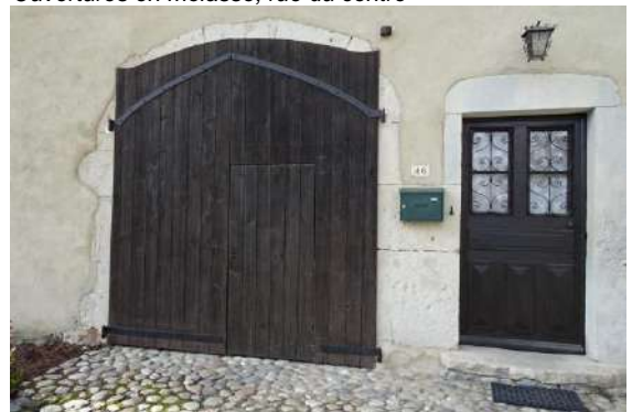
Ouvertures en calcaire, portes en bois, rue de Mont Pely
