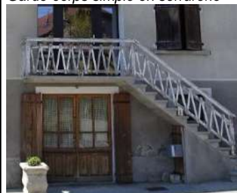
Garde-corps intéressant à conserver
