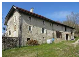
Impasse Eglise-60-70_OH-714 Corps de ferme en U, ayant conservé son volume
