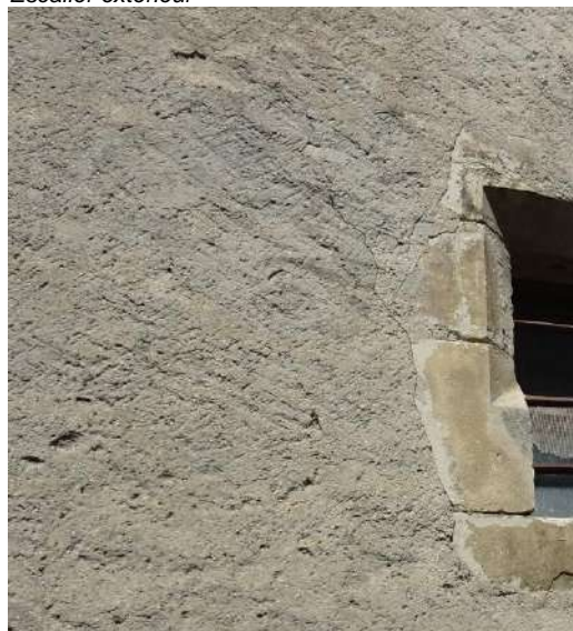
Finition d'enduit couvrant que l'on trouve à Clermont L'enduit s'arrête au nu des pierres de taille, ni en creux, ni en surépaisseur
