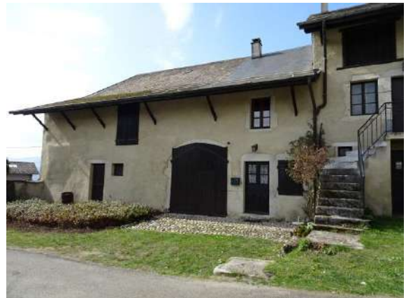
Ancienne ferme avec fonctions juxtaposées.
