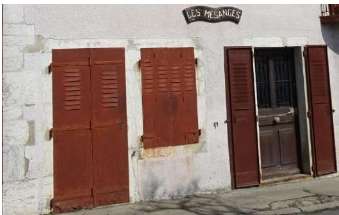
Rue du Centre, volets en métal.
