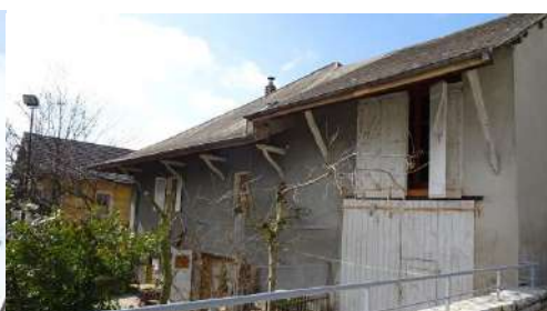
avancées de toitures caractéristiques de Clermont
