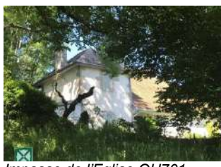
Impasse de l'Eglise OH701 En 1732 c'était la cure (une partie du bâtiment actuel)
