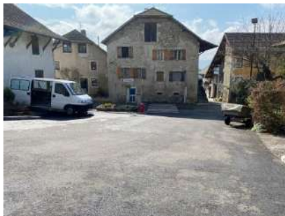
Voirie très élargie, entièrement imperméabilisé (enrobé)
