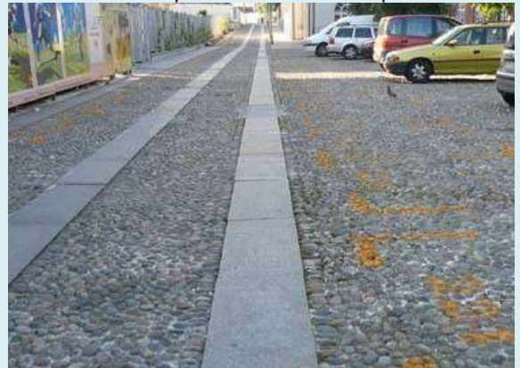
Calade pour l'ensemble de la rue et dalles de granit pour les bandes de roulement (Turin, Italie). Ce mode de disposition permet d'amoindrir le bruit du passage des voitures dans la rue.
