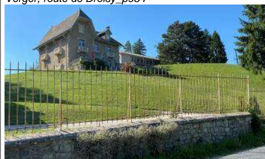
Clôture ancienne de qualité, route de Droisy_p2003
