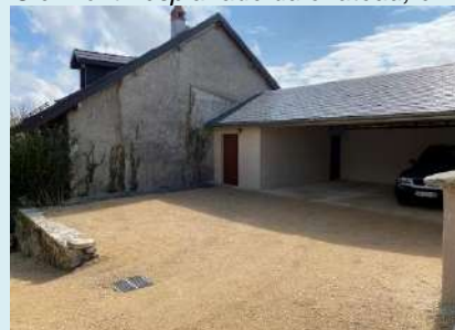
Cour en graves compactées Clermont Rue du Mont Pely_p1481-1479
