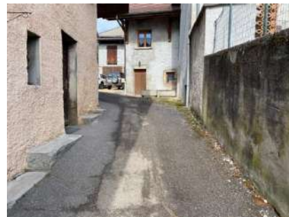
Imperméabilisation (enrobé) jusqu'en pied de mur et bâtiment
