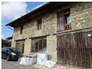
Rue de l'Ecole. Ouvertures d'atelier, grandes linteaux en métal (XIXe siècle)
