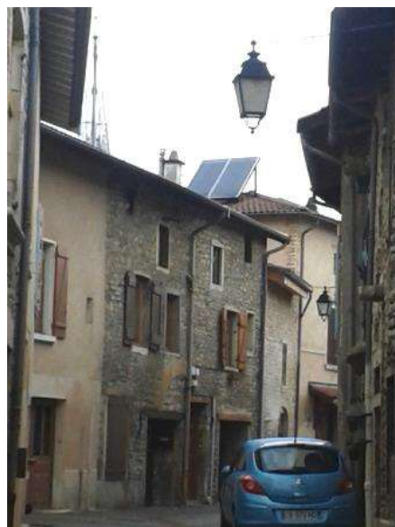
Panneau posé sur socle sur toiture en tuile creuse, en centre ancien !
