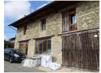
Rue de l'Ecole-63_OH-743_ Ancien atelier
