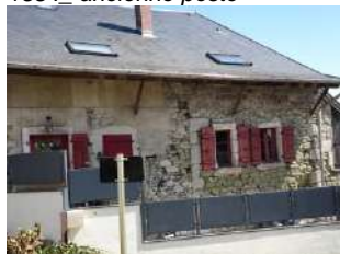
Rue du Centre-244_OH-1763-1483 Ancienne ferme
