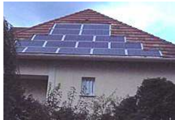
Pas d'adéquation avec la forme, effet de carreaux renforcé par la structure apparente.
