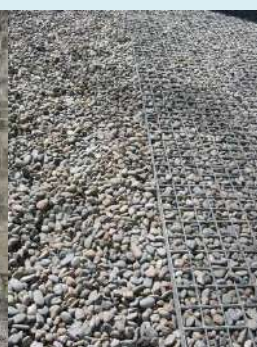
Caillebotis métallique pour circulation PMR
