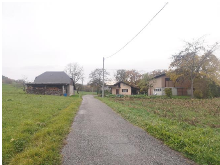
Photographie des constructions concernées.
