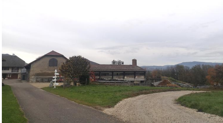
Photographie des constructions concernées.
