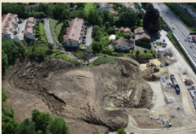
Glissement de terrain en 2021 à Bossey Photo Hélicoptère DAG
