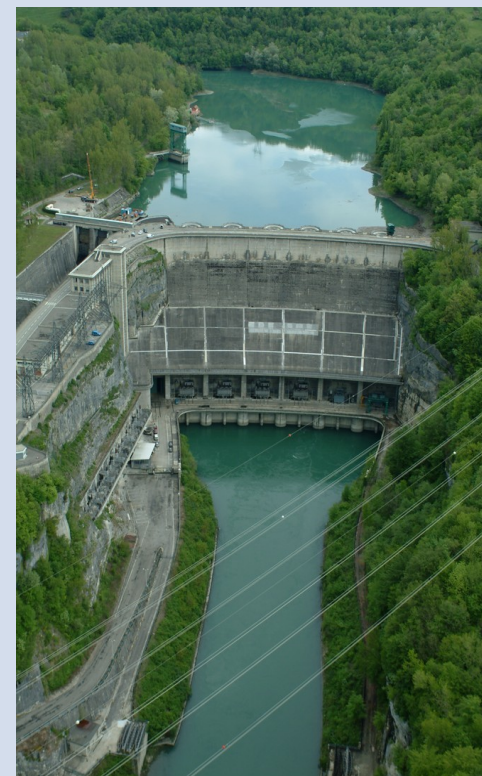
Barrage de Génissiat Photo CNR
