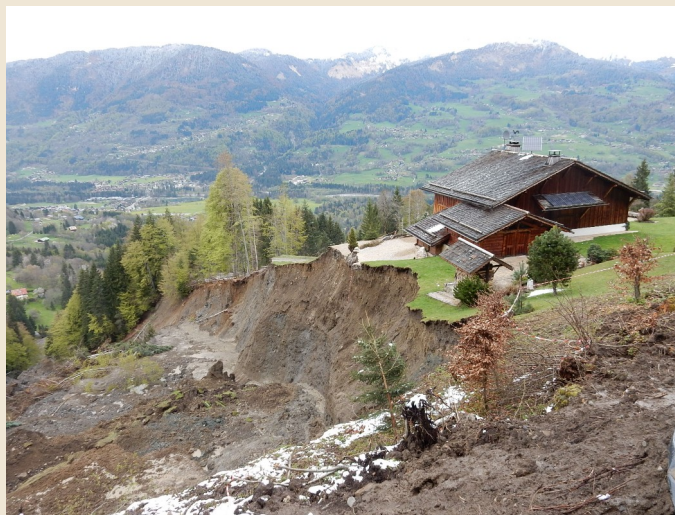
Glissement à Samoëns en 2016 Photo ONF-RTM 74
