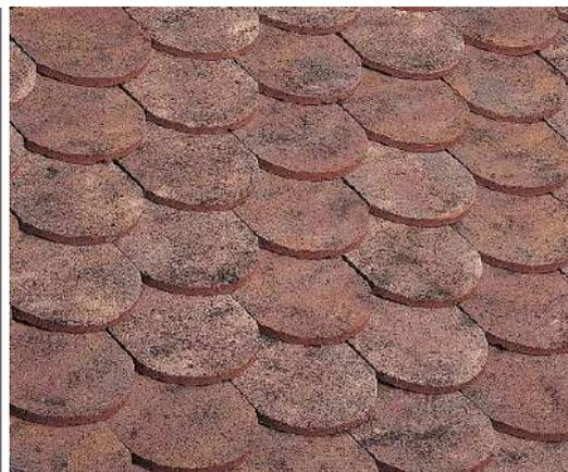
*Tuile plate traditionnelle, écaille. Pose traditionnelle (60/m<sup>2</sup>). Le recouvrement est important, seule la partie arrondie dépasse, les toitures sont plus épaisses, c'est la caractéristique des toitures anciennes*
