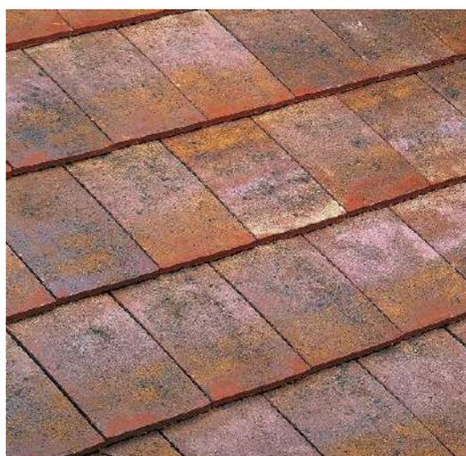
Tuiles plates à emboîtement, à petit moule, rectangulaires (22 tuiles/m<sup>2</sup>). Dimensions courantes 23,5/32cm.
