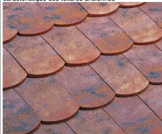
*Tuile plate à emboîtement, écailles (22/m<sup>2</sup>). Le recouvrement est minime, ce qui donne des toitures plus raides, moins épaisses, donc plus éloignées des toitures traditionnelles en tuiles écailles*
