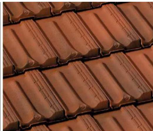
Tuile mécanique traditionnelle, à côte, (13 à 20 tuiles/m<sup>2</sup>). Dimensions courantes 21,5/35cm
