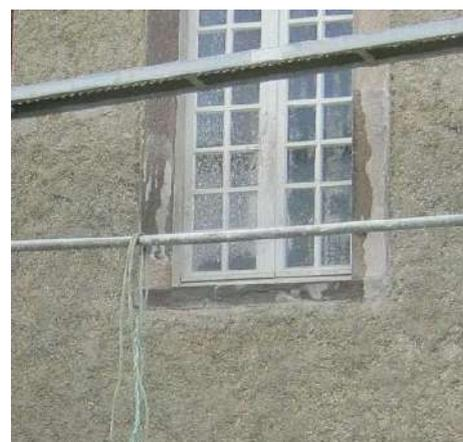
*OUI- enduit isolant remplaçant l'enduit existant*
