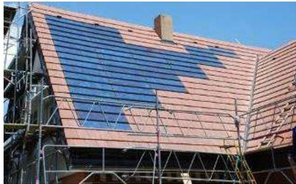
*Non respect des ouvertures et des lignes de la toiture ce qui crée un « trou »*
