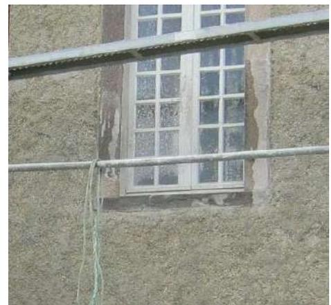
*OUI- enduit isolant remplaçant l'enduit existant*
