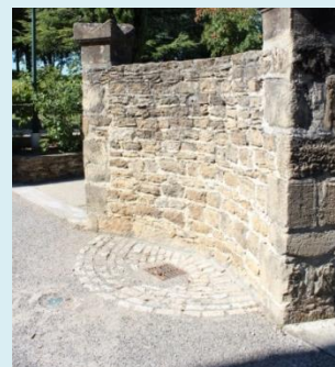
Exemple: pavés jointoyés au sable (sol perméable) et stabilisé (Chabrillan, Drôme)
