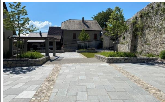
Clermont : Aménagement de l'esplanade de l'église Dallage de pierres de luzerne et bandes type calade
