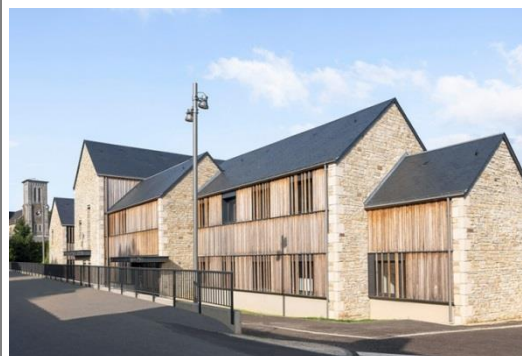
Principe de cette construction récente : des gabarits traditionnels, une façade contemporaine. Centre hospitalier Avranche 50, Saba architectes
