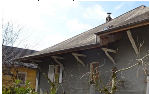
Console charpentée avec jambe de force courbe
