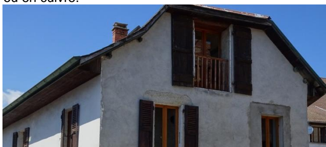
Coyau en bas de pente (la pente du toit s'adoucit)
