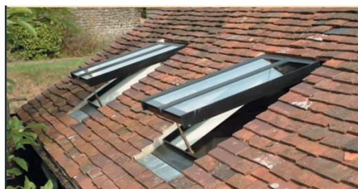
Les fenêtres de toit « patrimoine » avec pare close centrale sont mieux adaptées aux toitures anciennes
