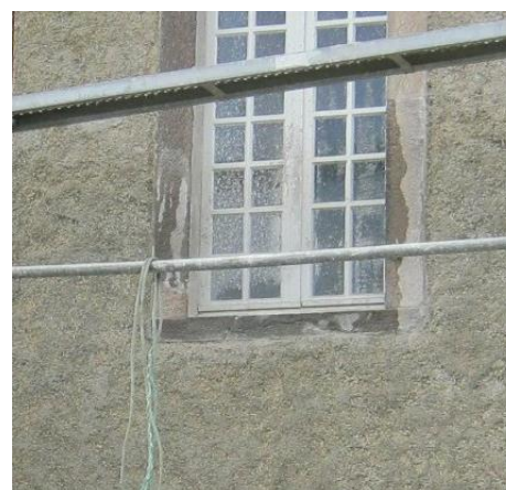
OUI- enduit isolant remplaçant l'enduit existant
