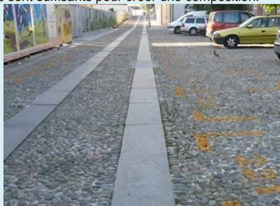
Calade pour l'ensemble de la rue et dalles de granit pour les bandes de roulement (Turin, Italie). Ce mode de disposition permet d'amoindrir le bruit du passage des voitures dans la rue.
