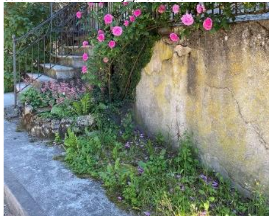
Pied de mur végétalisé - Rue du Centre_p746
