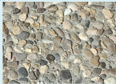
Béton avec petits galets roulés en réinterprétation de la « calade »
