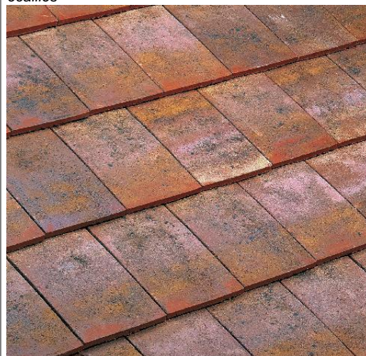
Tuiles plates à emboîtement, à petit moule, rectangulaires (22 tuiles/m 2 ). Dimensions courantes 23,5/32cm.
