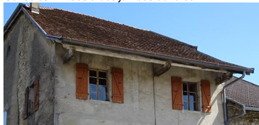
Le débord de toit est supporté par les poutres horizontales traversant la maçonnerie
