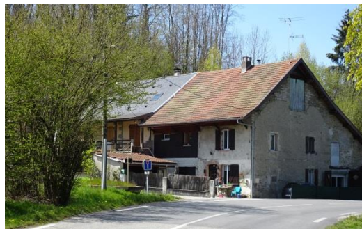
Bâtiment patrimonial intéressant, Impasse des Esserts-6-20_pOH-1201-1204
