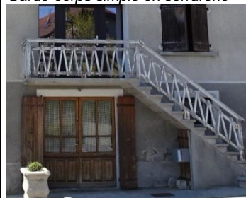
Garde-corps intéressant à conserver
