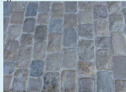
Pavage jointoyé – place de l'église à Haute-Bonne
