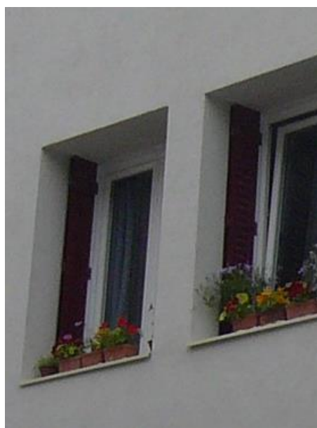
NON – panneaux isolants qui masquent la modénature de la façade et créent une surépaisseur et diminuent par force la surface vitrée
