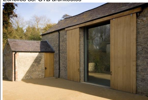
Volets coulissants pour occulter une baie vitrée.
