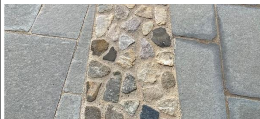
Clermont : Aménagement de l'esplanade de l'église Dallage de pierres de luzerne et bandes type calade
