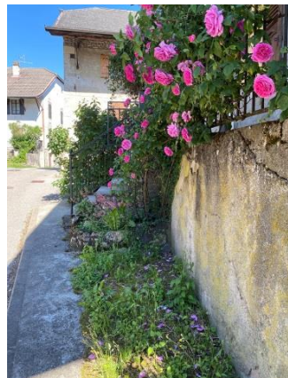
Clermont : pied de mur végétalisé
