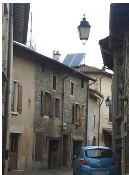
Panneau posé sur socle sur toiture en tuile creuse, en centre ancien !
