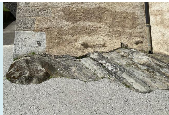
Clermont : Aménagement de l'esplanade de l'église – Préservation de l'affleurement rocheux
