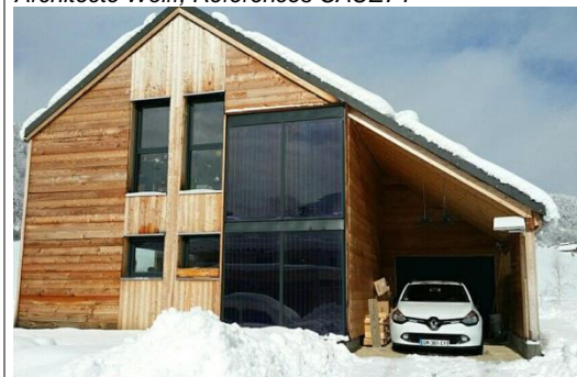
Panneaux solaires composant une façade. Source : Solisart.fr
