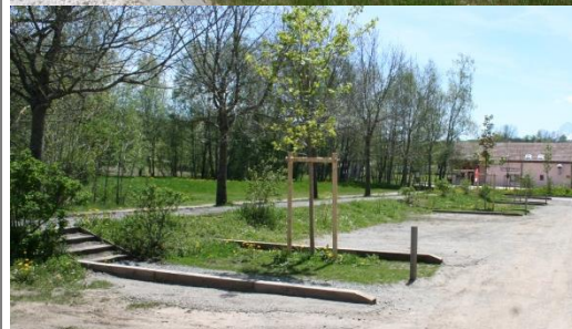
Espace de stationnement, revêtement perméable et planté
