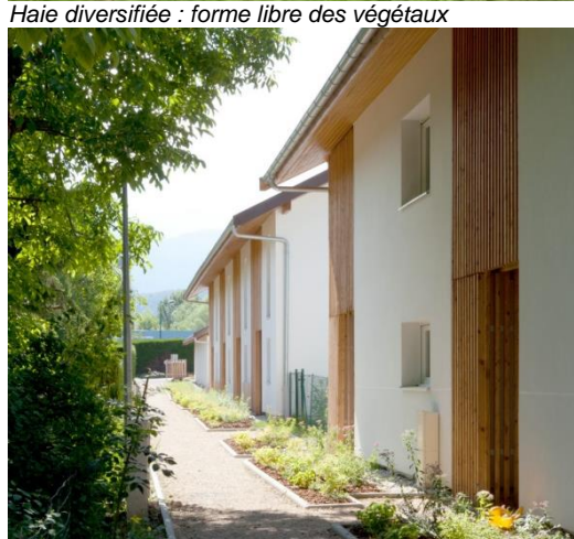
Abords perméables. Opération de location-accession à Saint Jorioz Arch. Favre & Libes, références CAUE74.
