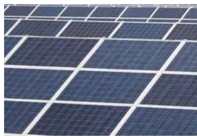
Les panneaux polycristallins à facettes, les lignes argentées apparentes.
