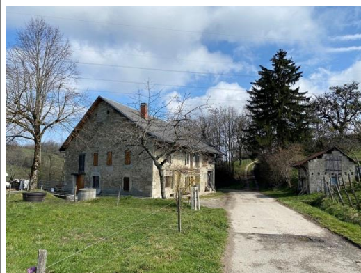
Abords de construction, rue des Corbattes_p567
