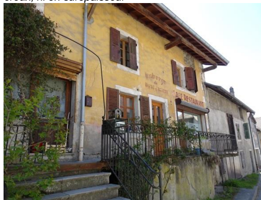
Enduit couvrant, recouvert d'un badigeon coloré, présentant un décor peint simplifié
