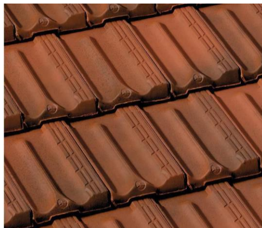
Tuile mécanique traditionnelle, à côte, (13 à 20 tuiles/m 2 ). Dimensions courantes 21,5/35cm
