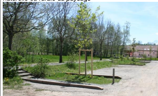
Espace de stationnement, revêtement perméable et planté
