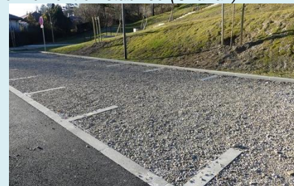
Circulation en enrobé et emplacements en stabilisé (Bonne, Haute-Savoie)
