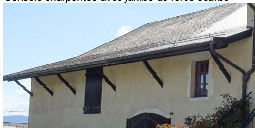
Consoles limitées à des jambes de force
