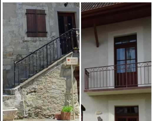
Garde-corps simple en serrurerie
