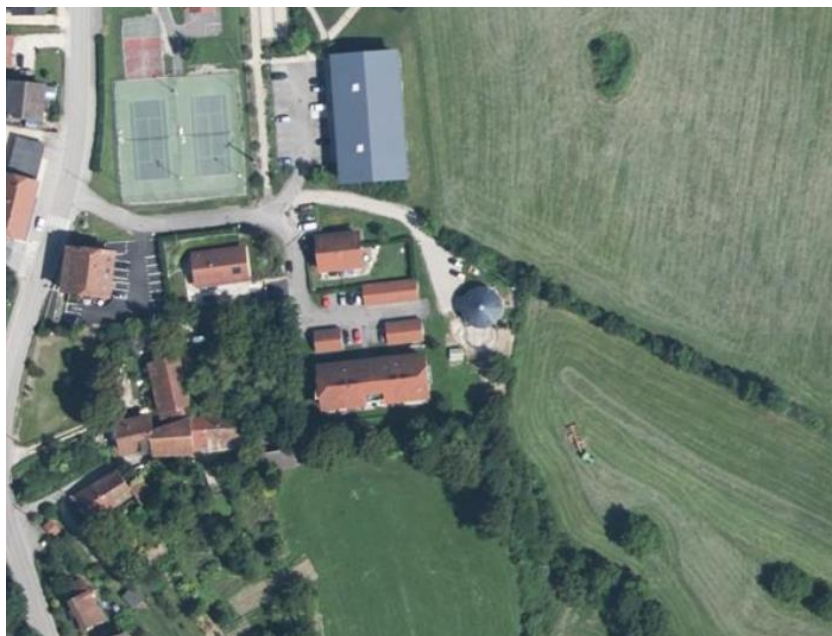
Vue aérienne de l'existant, où la haie marque bien la limite du secteur d'intérêt.
