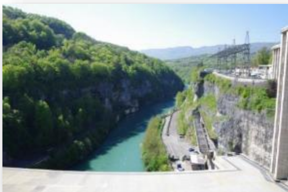
Centrale hydroélectrique de génissiat, sur le Rhône. Source : AGRESTIS.
