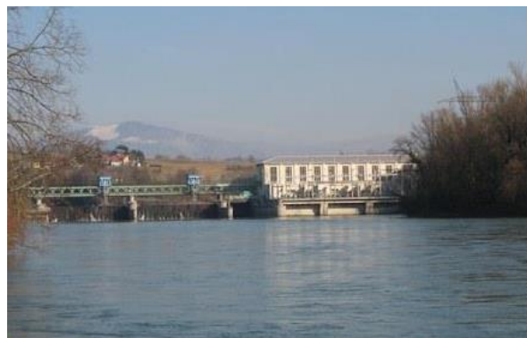
Barrage de Seyssel Corbonod
