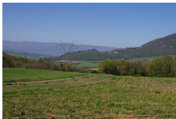
Ligne électrique à haute-tension.
