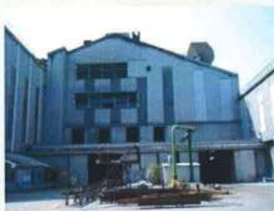
FERROPEM – Établissement d'Angletfort
