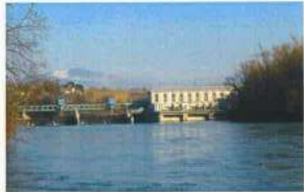
Barrage de Seyssel Corbonod
